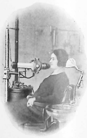
FIG. 26. — Appareil dentaire en place pour la radiographie des incisives.
