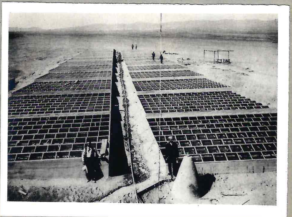
Fig. N o 8.- Destilador Solar construido en Las Salinas, Chile, en 1872
