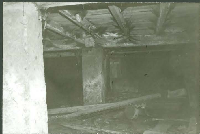
16. VIGAS MAESTRAS BAJO MUROS ESTRUCTURALES
