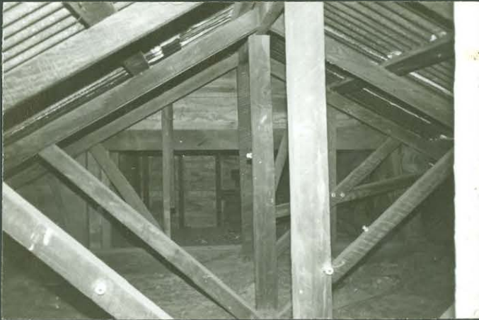
7. TIJERAL DE LA VIVIENDA LAS DIAGONALES ACORTAN LUZ DE LAS PIERNAS.
