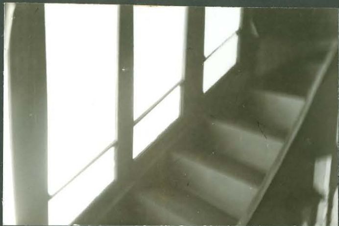
24. ESCALERA AL SEGUNDO NIVEL ACUSADA EN EL VANO
