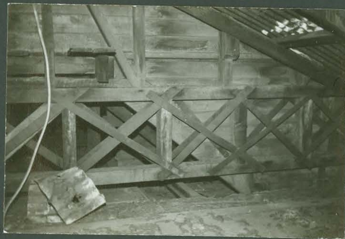
12. VIGA EN CELOSIA PARALELA A CUMBRE RA
