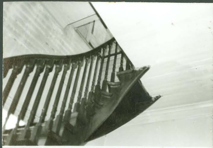
23. DETALLE ESCALERA DE ACCESO A MIRADOR
