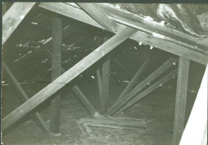
9. DETALLE ESTRUCTURA DE TECHUMBRE
