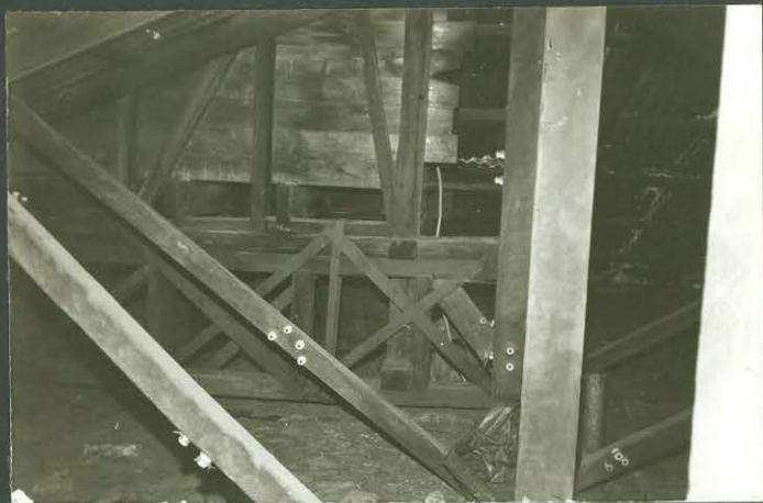
13. AISLADORES DE LOZA DE ANTIGUO TENDIDO ELECTRICO
