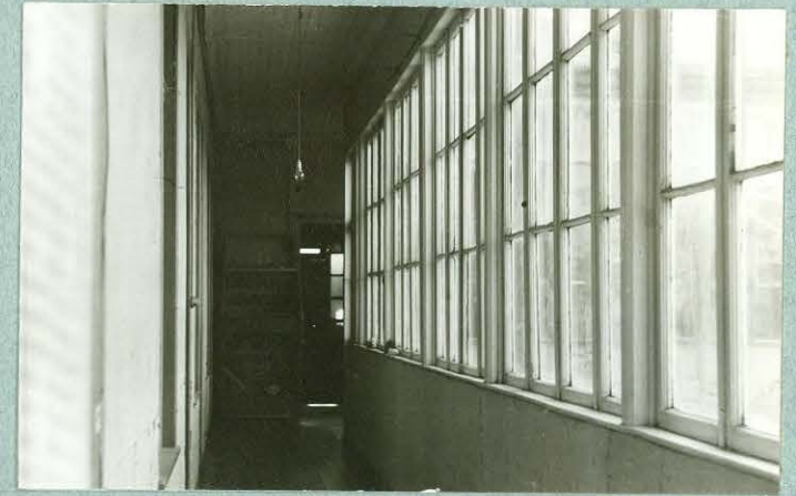
D8 Galería, hacia la puerta principal.
