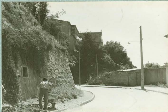
D3 Desde Camino de Cintura (sur)
