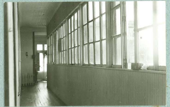
D14 Galería hacia balcón de fachada principal. N.E.
