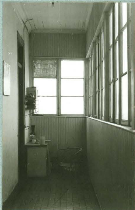
D17 Galería sin transformar
