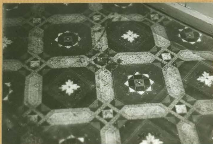
35. detalle de revestimiento de piso-linoleo - en tercer piso.
