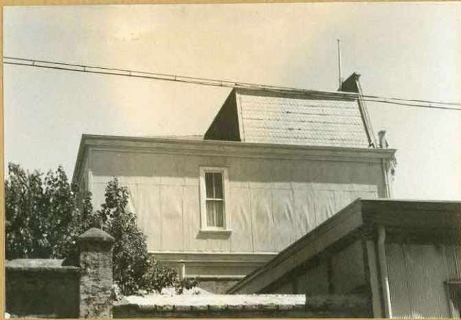
5. fachada este, vista desde la calle Levarte.
