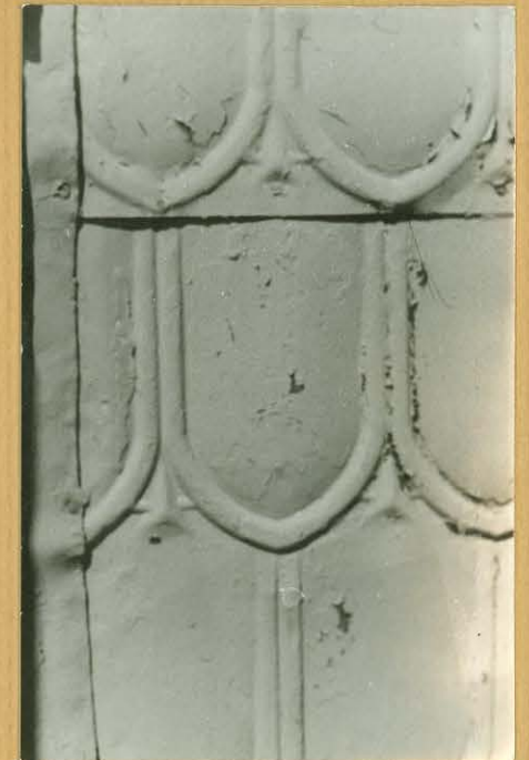
9. revestimiento exterior en mansarda.
