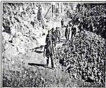
Avenida Colón, cerro de La Cruz, apertura de la Avenida, desmonte del cerro, la Junta de reconstrucción visita estos sitios.
