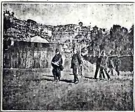
Al enfrentar á la calle de la Merced, final de la misma, desde la Avenida Colón, la Junta en visita de inspección.
