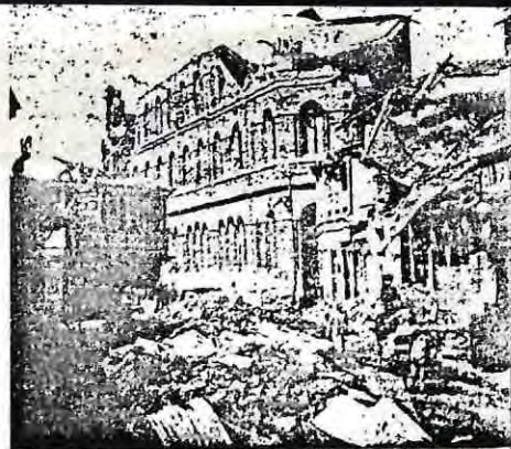
Una calle porteña con los escombros de sus edificios destruidos, después de la trágica noche de agosto de 1906.
