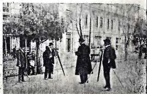
Nivelando en la Gran Avenida.
