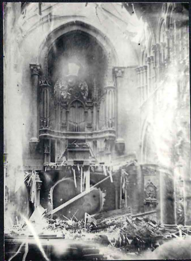
10 Vista de los daños del interior de la iglesia.
