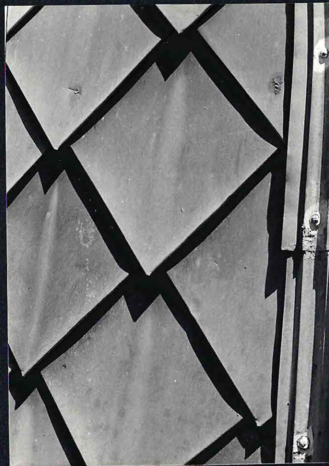
46 Revestimiento externo de la aguja.
