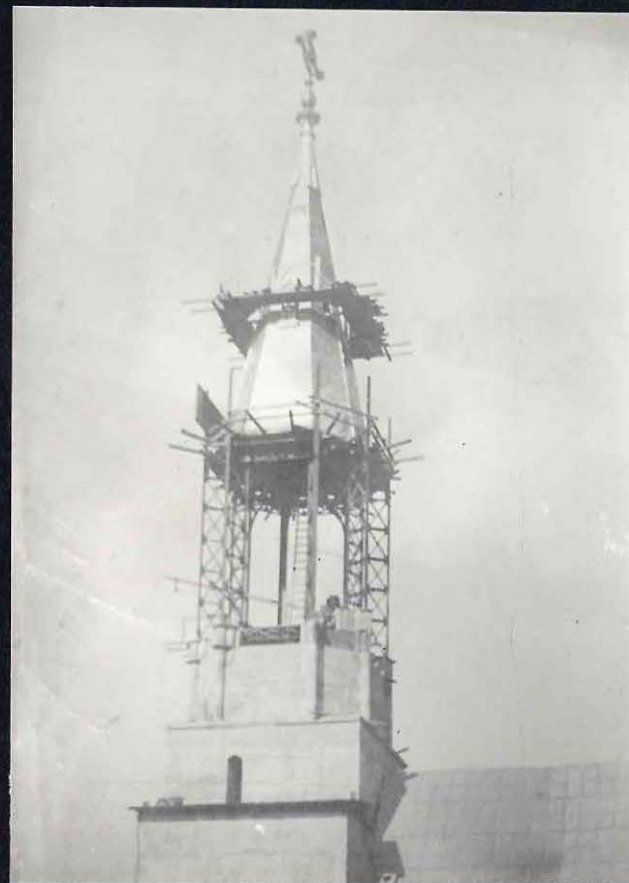
14 Segunda etapa de los trabajos. Reconstrucción de la torre y construcción de la aguja.
