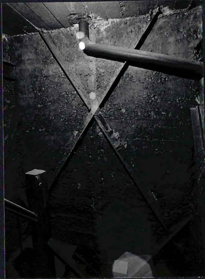
43 Interior de la base de la torre.
