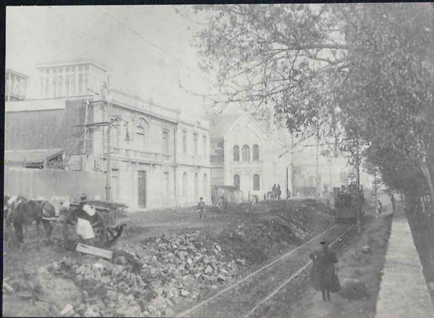
11 Trabajos de levantamiento de nivel en calle Independencia.
