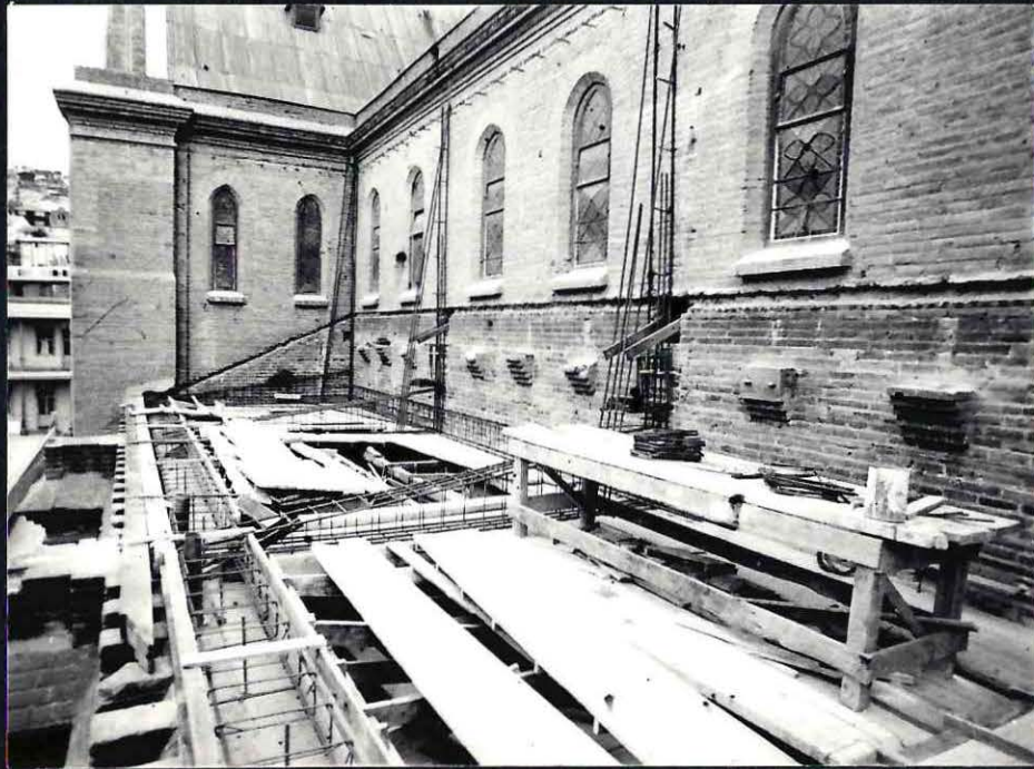
47 Construcción de los arbotantes invertidos.
