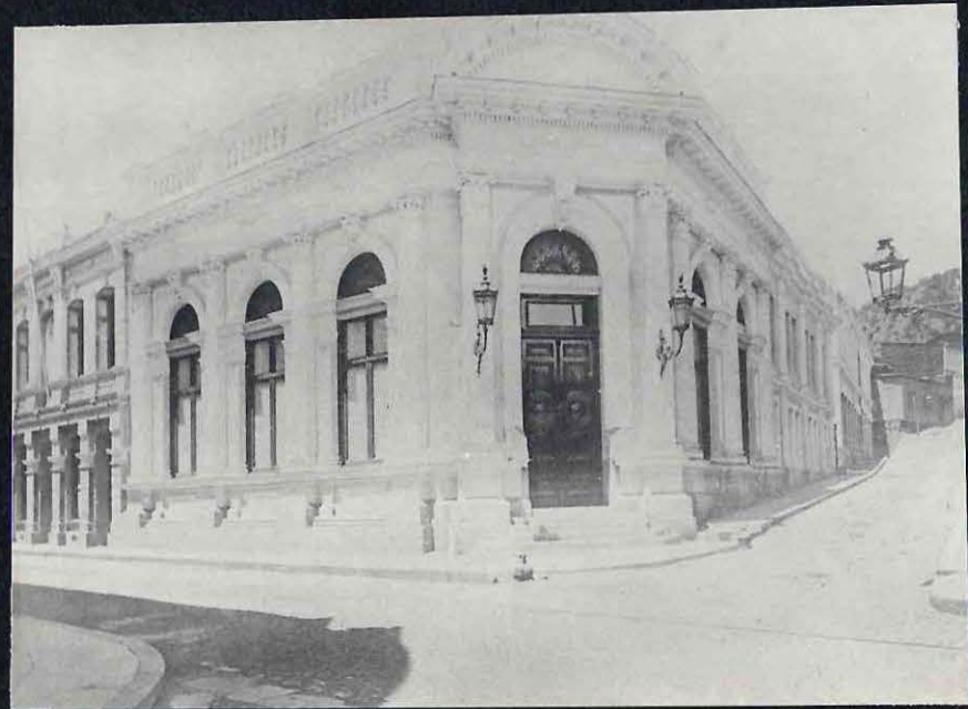
6 Edificio del Banco Nacional que se hallaba ubicado en la esquina de las calles Prat y Urriola. Fue proyectado por Arturo Meakin.
