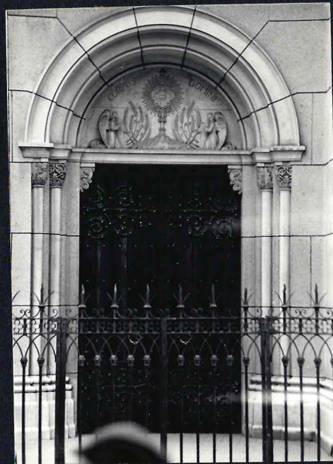
40 Puerta de acceso a una de las naves laterales.
