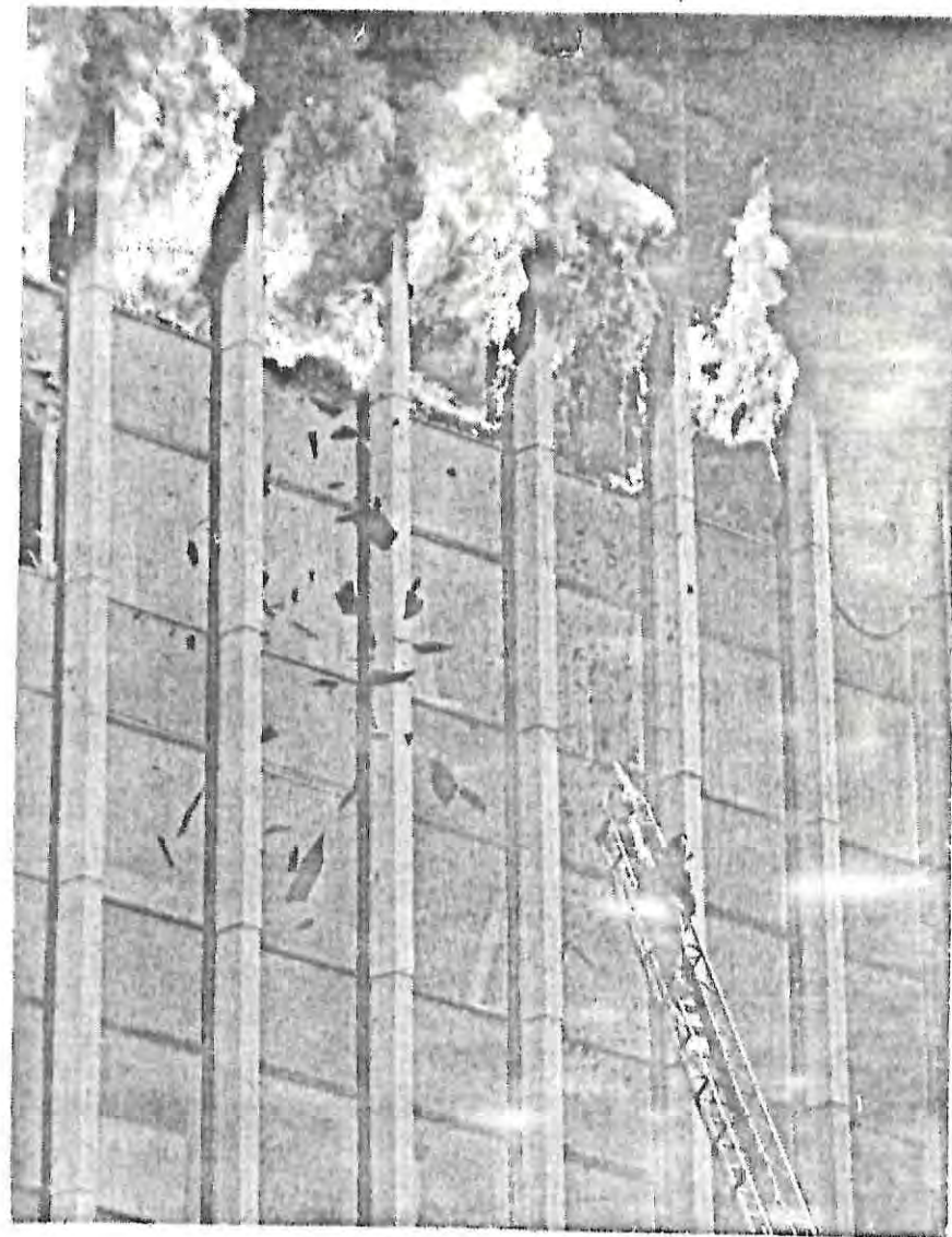
La foto muestra la potencia calórica de las llamas en un momento del incendio, se puede observar cómo estallan los vidrios.
