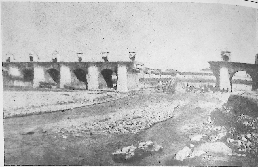
FIG. 1141.—EL PUENTE DE CAL Y CANTO, PARCIALMENTE DESTRUÍDO. (Fotografía, Sala Medina. Biblioteca Nacional.)
