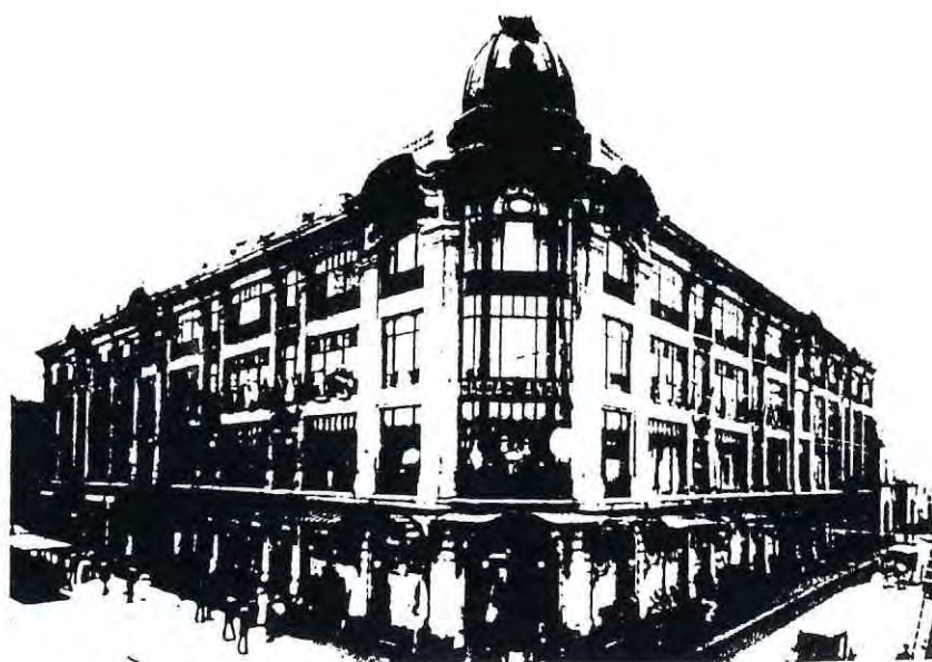
EDIFICIO GATH y CHAVEZ, estructura de acero recubierto con hormigón levantada en 1909.
