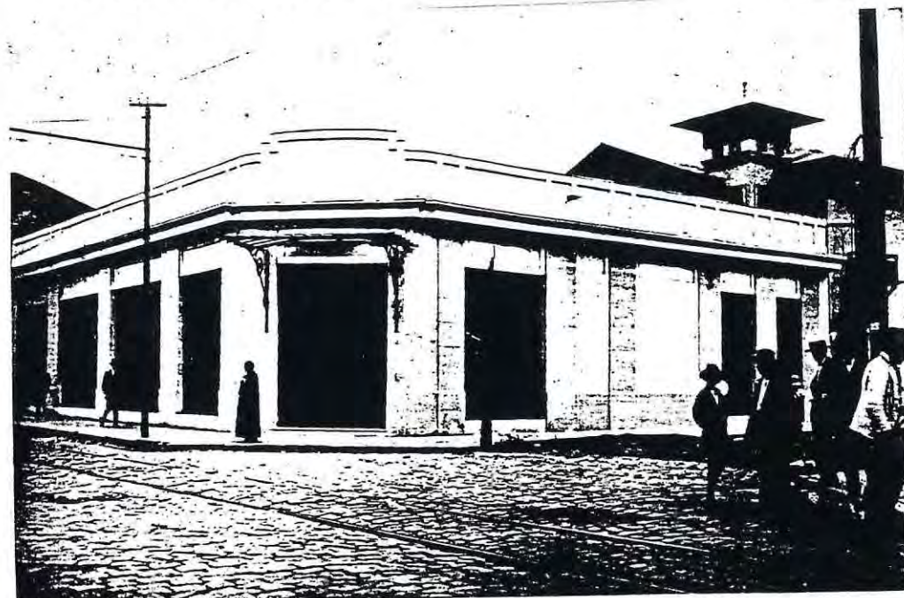
EDIFICIO DE CONCRETO EN TALCA, DESPUÉS DEL TERREMOTO, NO SUFRIÓ DAÑOS - 1928
