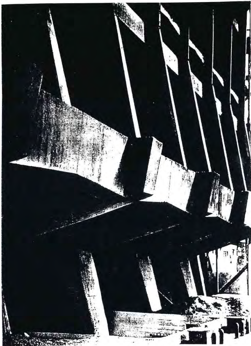
en construcción de edificio manufacturas Sumar SA.
