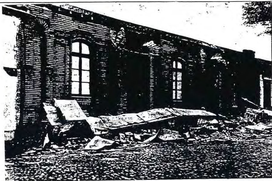
ALBAÑILERÍAS DESPUÉS DEL TERREMOTO EN TALCA - 1928
