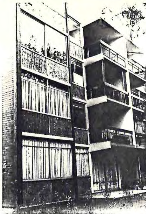
FACHADA ANTERIOR - DORMITORIOS Y TERRAZA DEL ESTAR COMER.
