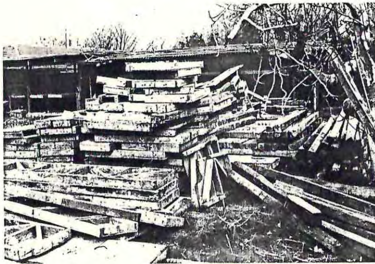
MOLDAJES DE MADERA PARA SOBRECIMENTOS Y CUARTONES DE ALZAPRIMAS.
