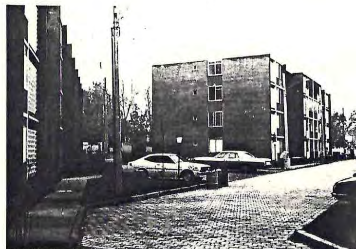
EL CONJUNTO DESDE EL INTERIOR - PASAJE VEHICULAR Y ESTACIONAMIENTOS
