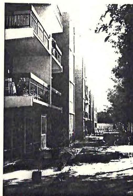
FACHADA ANTERI- OR DETALLE MURO Y VIBAS TERRAZA
