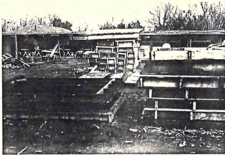
ANDAMIOS DE DESENCOFRADOS COMPLEMENTA- RIOS CONFECCIONADOS EN MADERA
