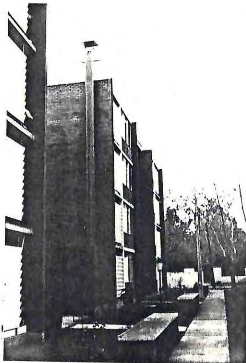
FACHADA POSTERIOR BLOQUE A.
