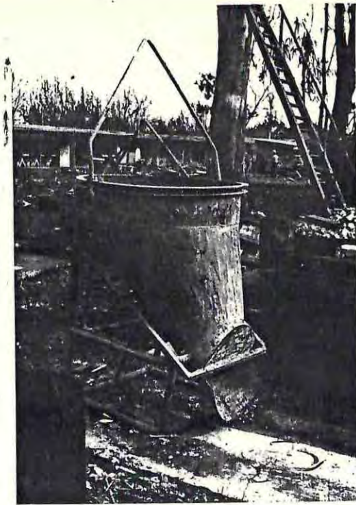
CAPACHO UTILIZADO PARA EL HORMIGONADO
