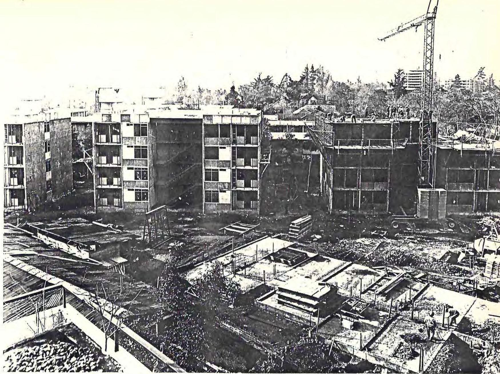
VISION GENERAL DE LA OBRA EN AVDA. COLON, EN CONSTRUCCION - LOS BLOQUES B Y C SE ENCUENTRAN EN ETAPA DE TERMINACIONES < SE OBSERVAN DISTINTOS GRADOS DE AVANCE > EL BLOQUE A EN ARMADO DE LAS LOSAS DE LA PRIMERA FASE DEL CUARTO PISO, COLOCACION DE ANTEPECHOS Y ESCALERA EN PRIMER Y SEGUNDO PISO. - EL BLOQUE E EN ETAPA DE SOBRECIMIENTO - EL BLOQUE D EN FUNDACIONES Y CONFECCION DE ALCANTARRILLADOS.
